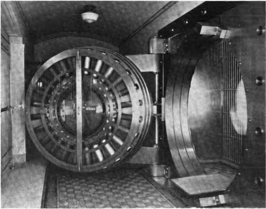
Twenty-two ton vault door
